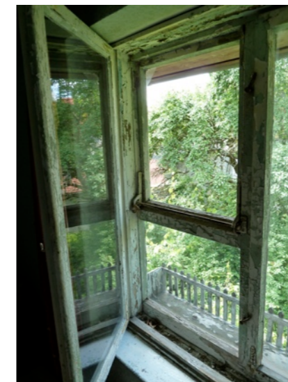
bauzeitliches Fenster, Zustand 5/2011 alle Fotos dieser Seite: Martin Weber
