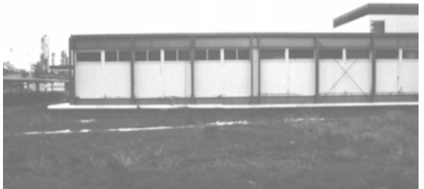
Abb. 5: Erweiterung der Waschkabine um 3 Konstruktionsfelder
