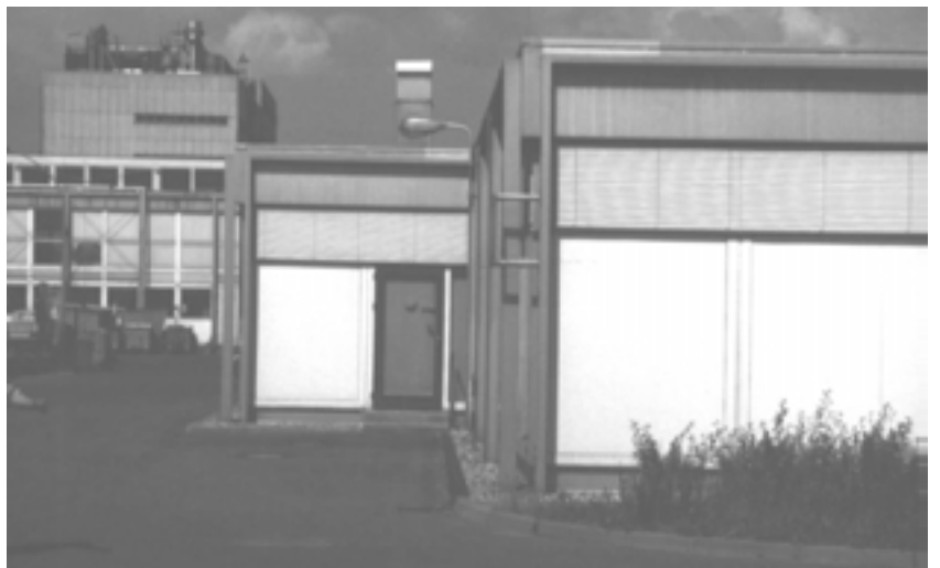
Abb. 8: Blick gegen die Erweiterung der Feuerwache nach Süden und Westen Im Hintergrund das Werkstattgebäude und Kraftwerk
