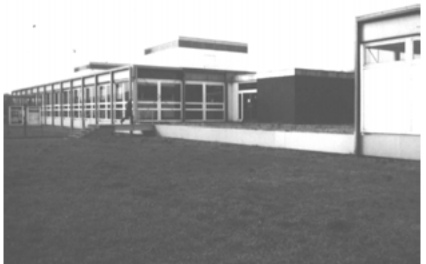
Abb. 13: Blick auf das Sozialgebäude von Nordosten mit Zwischenbereich ohne Pergola
