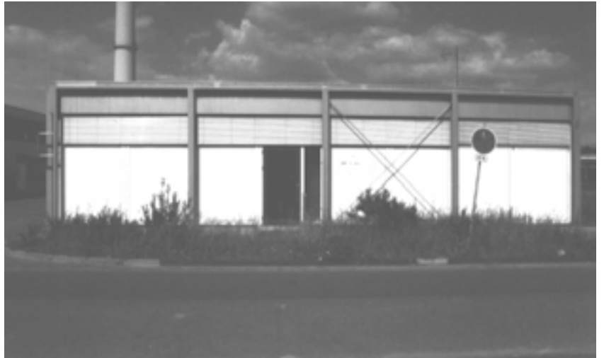
Abb. 7: Blick gegen die Erweiterung der Feuerwache nach Süden
