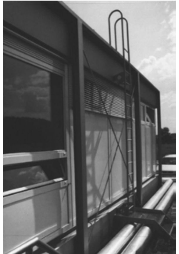
Abb. 9: Die neuen Außenwände am Kasinotrakt
