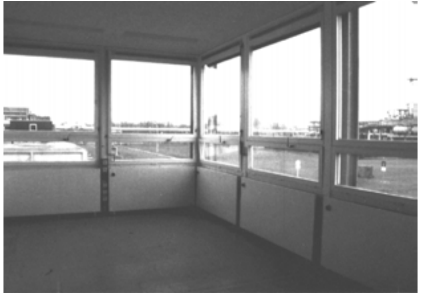
Abb. 12: Innenansicht des ehemaligen Laborgebäudes (Nord-Ostecke), Blick auf die Feuerwache und den Treppenturm des Werkstattgebäudes
