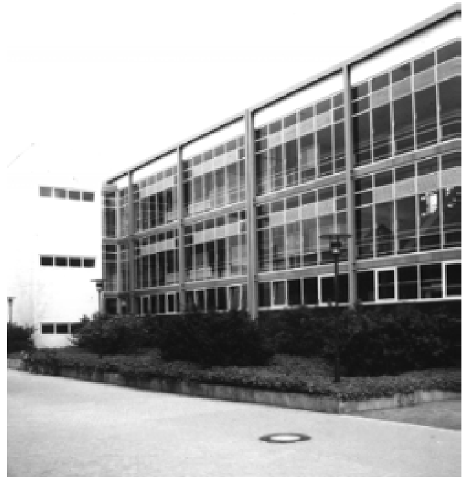
Ansicht von Südosten, Foto des Verfassers
