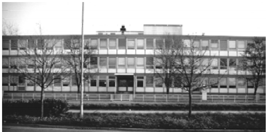
Verlagsgebäude für "Burda - Moden" Offenburg Südseite, Oktober 1998
