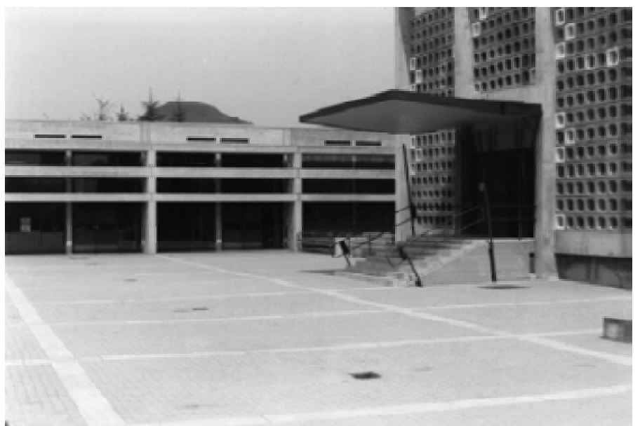
Ansicht Eingang, Foto der Verfasserin, heutiger Zustand
